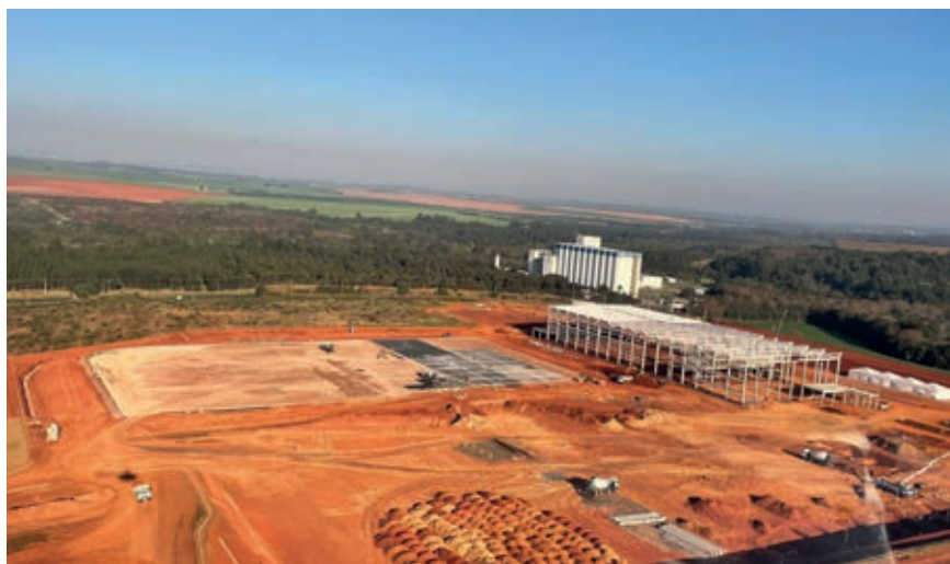
A Cristalpet já iniciou o seu investimento de R$ 447 milhões no Distrito Industrial de Ponta Grossa, para a construção de uma fábrica de embalagens 'PET'
